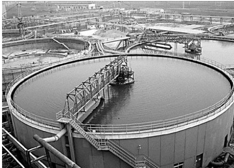
Слика 31. Постројка за пречистување на фекален отпад
